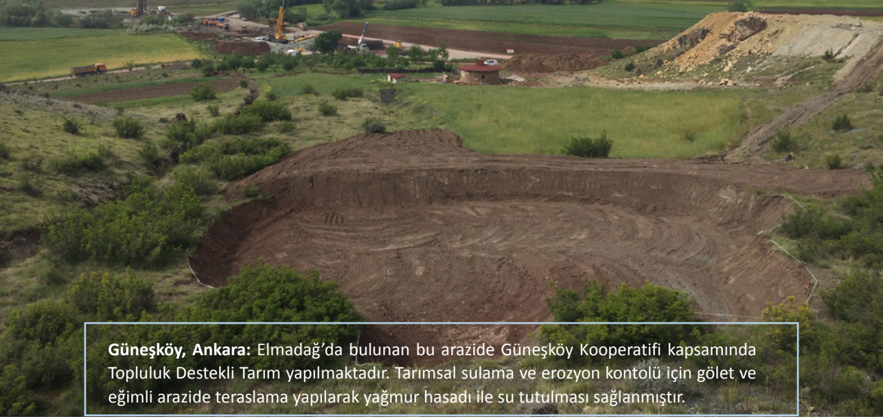
Şekil 34. Güneşköy/Ankara yağmur suyu gölet inşaatı (Fotoğraf: Gökmen, 2014)
