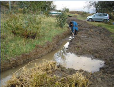
Şekil 32. Datça/Muğla insan gücüyle hendek yapımı örneği (Fotoğraf: Kınıkoğlu, 2016)
