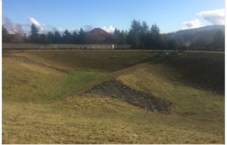
Şekil 24. Seattle yağmur suyu tutma gölleri ve savak uygulaması (Fotoğraf: Tokuş, 2017)
