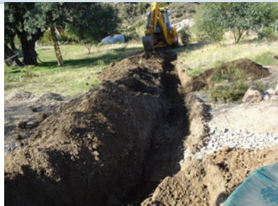
Şekil 33. Datça/Muğla iş makinesiyle hendek yapımı örneği (Fotoğraf: Kınıkoğlu, 2016)
